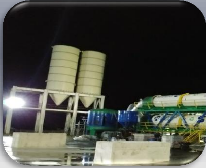
150 ton kapasiteli kurutulmuş arıtma çamuru stok siloları Toplam 300 ton
